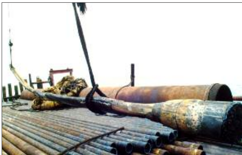
Figura 4. Tubería de 7" de diámetro, fabricada con acero tipo P-110, 26 Lb/pie, colapsada
