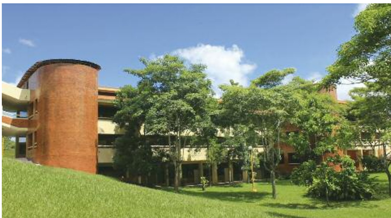
Vista parcial de la Universidad Olmeca
