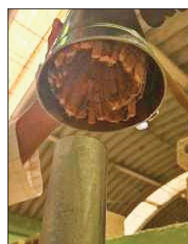
Figura 27 y 28. Instalación del filtro sobre el tubular
